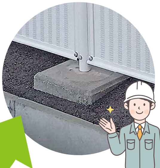
フェンス基礎施工例
